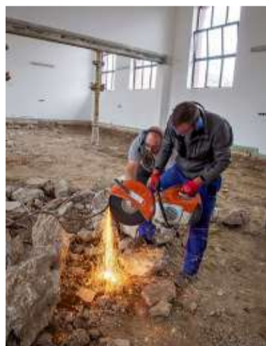
Dürfen wir vorstellen: der Theatersaal in spe. Noch haben Bauarbeiter mit den Abrissarbeiten allerhand zu tun.
